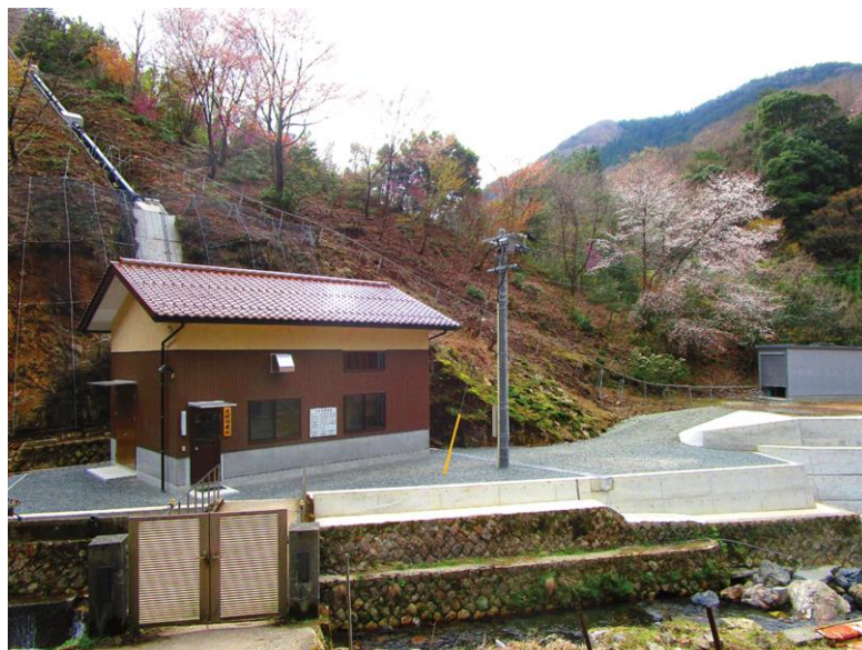
【更新後の発電所】
